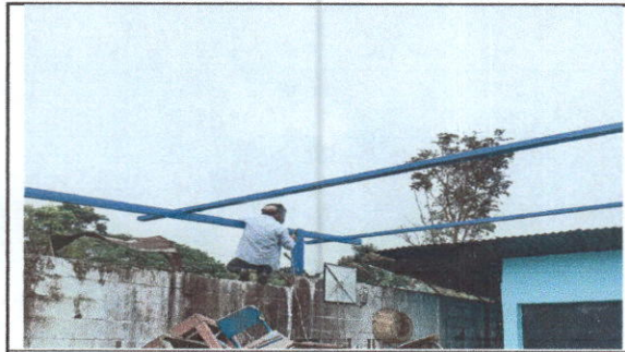
Foto 2: Sustitución de estructura de soporte de madera, por metal
