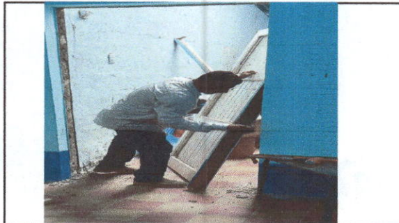
Foto 4: Sustitución de puerta
