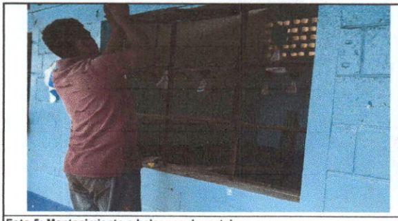
Foto 5: Mantenimiento a balcones de metal
