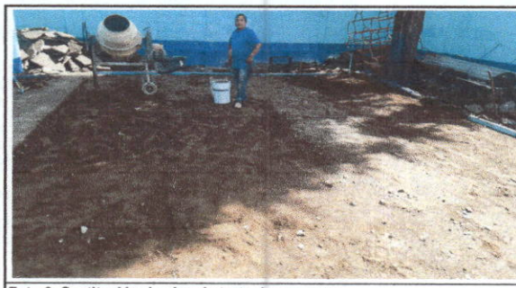
Foto 6: Sustitución de piso de torta de concreto
